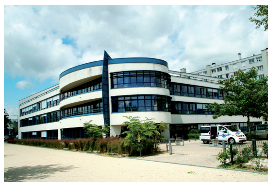
Entrée du CRRF Pasteur
