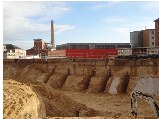
Mai 2012 - Le chantier
