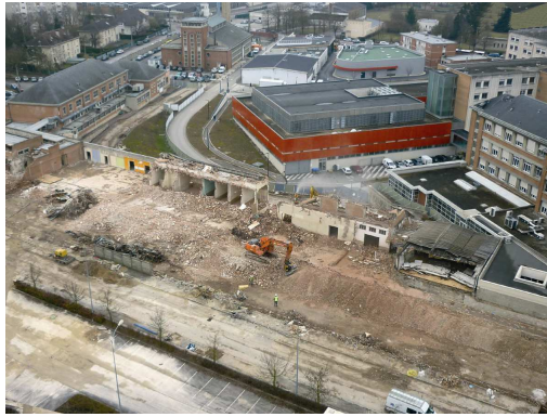
Avril 2012 - Le chantier
