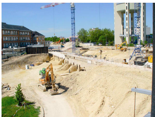
Mai 2012 - Le chantier
