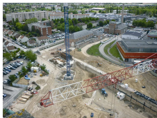
Mai 2012 - Le chantier
